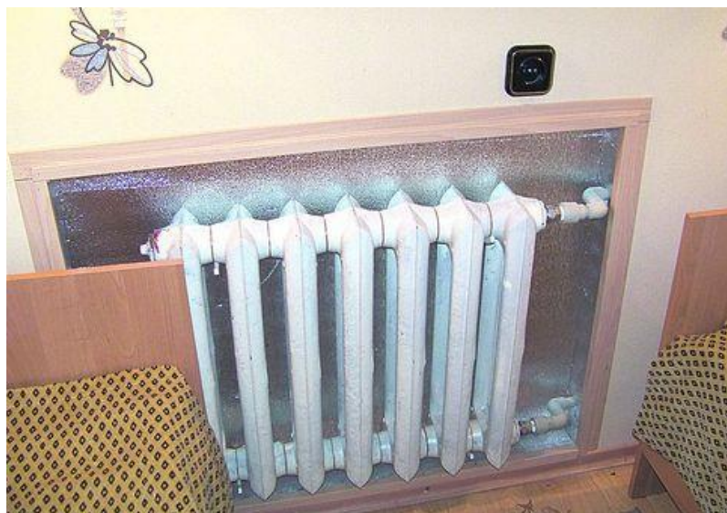
Пример установки теплоотражающего экрана
